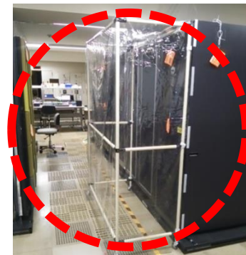
【施工例 (BOXタイプ)】
