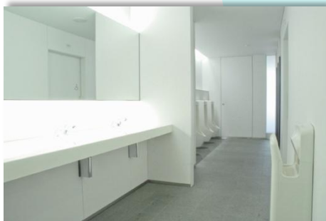
【給排水衛生設備】
