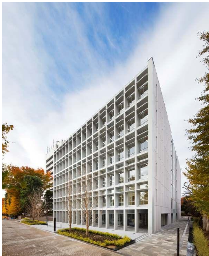
NTT東日本研修センター 5号館
