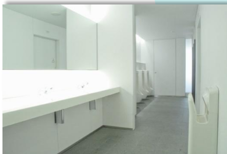
【給排水衛生設備】
