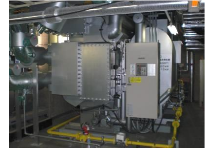
▲高効率ガス吸収式冷温水発生機 (フォーシーズンズホテル椿山荘)
