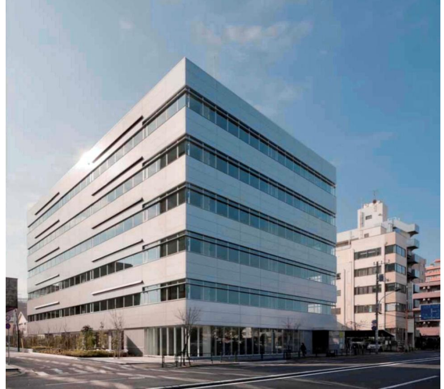
ネクストサイト深川ビル
