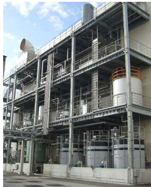
原薬合成工場施工例
