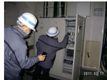
▲NTTグループ通信施設での復旧活動
