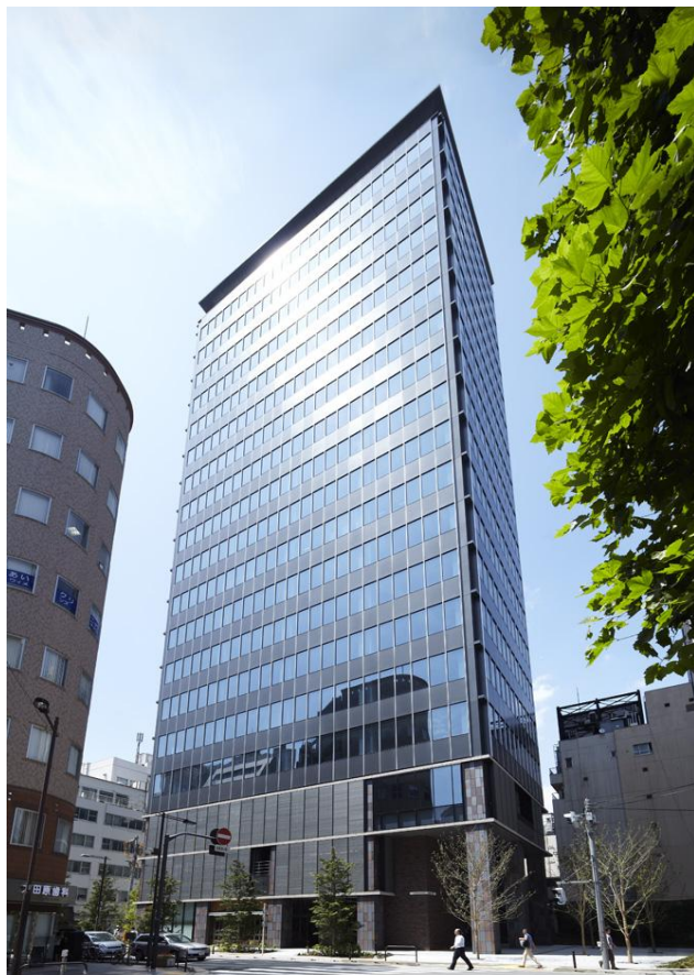
アーバンネット神田ビル
