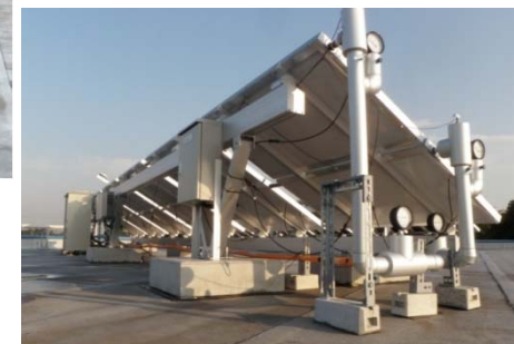
▲太陽熱電池パネルの裏面に熱取得装置を搭載
