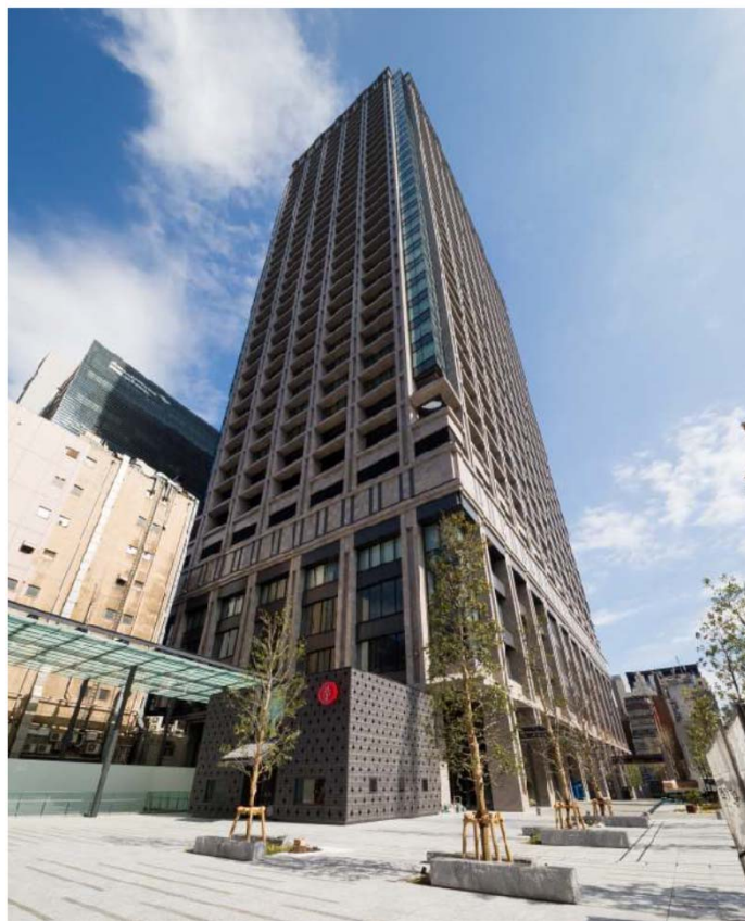
東京日本橋タワー
