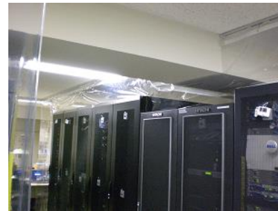
【施工例 (梁下施工)】
