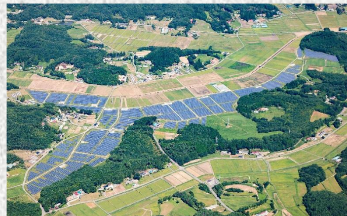
復興モデルエリアの特高変電所を備えた スーパーメガソーラー
