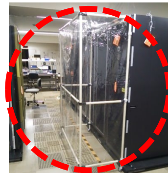
【施工例 (BOXタイプ)】
