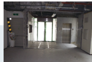
● エントランス改修前
