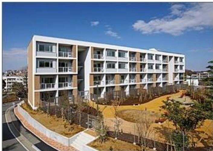
東京ガス(株)磯子社宅
