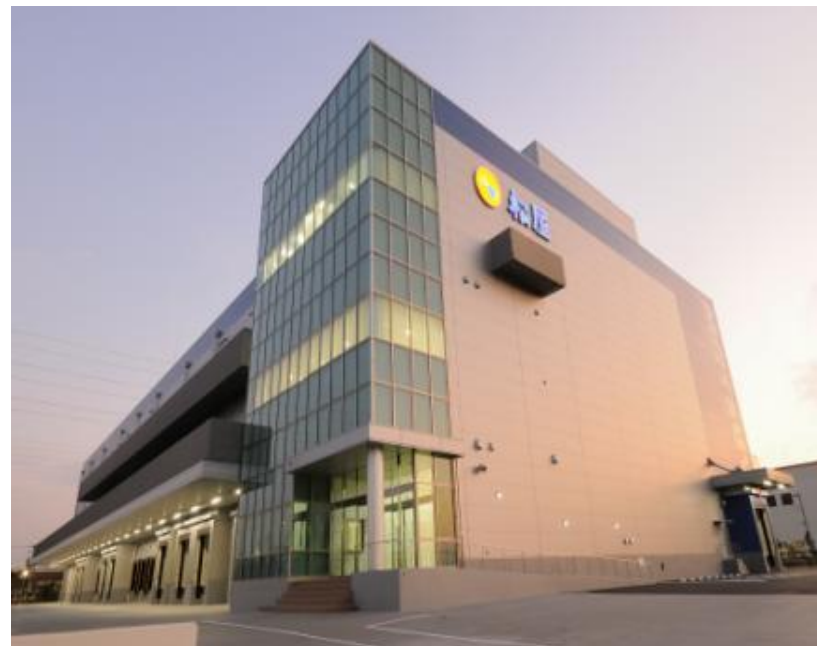
松屋フーズ 川島生産物流センター
