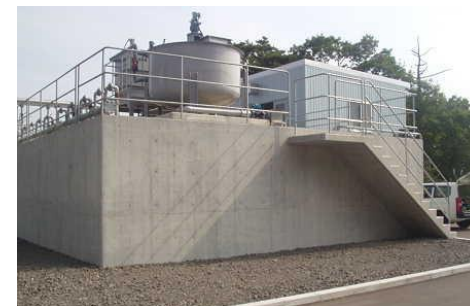
廃水処理施設 施工例
