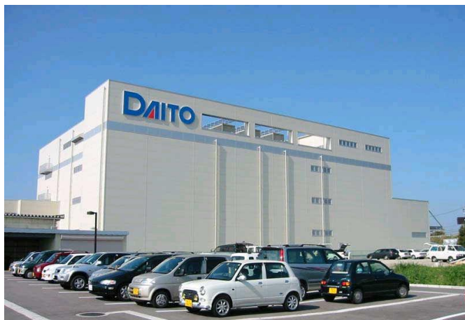
新製剤工場 施工例
