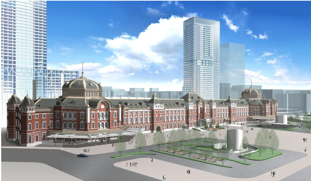
東京駅丸の内駅舎保存・復原
