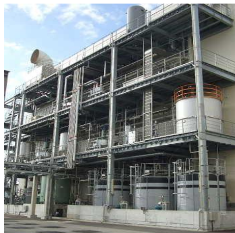
原薬合成工場 施工例
