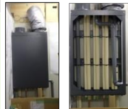
【ミニバルコニーユニット】 (BOX内に複数配管を一体的に組込) (製造元:ニッケイ)
