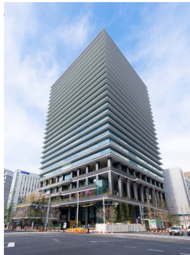
東京スクエアガーデン(京橋) 【6階に常設展示場「HIBIYA E&S PLAZA」】
