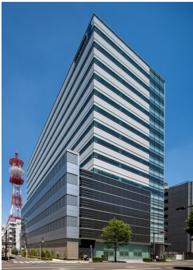
NTT東日本青葉通ビル
