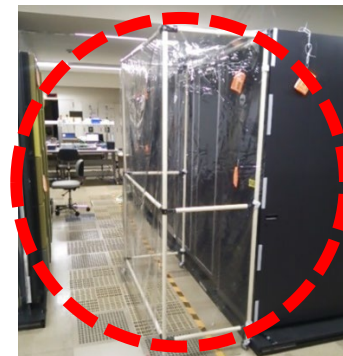
【施工例 (BOXタイプ)】
