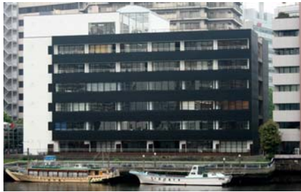
Lattice shibaura (日土地芝浦ビル)
