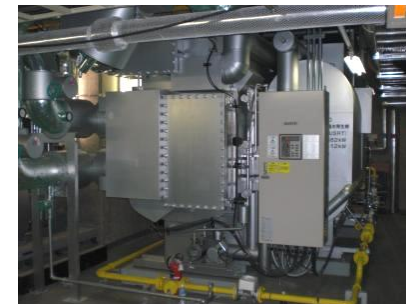
▲高効率ガス吸収式冷温水発生機 (フォーシーズンズホテル椿山荘)
