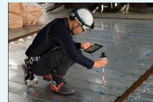
【レーザー墨出し機による インサート墨出し作業】
