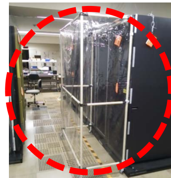
【施工例 (BOXタイプ)】
