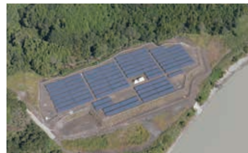
富士宮太陽光発電所構築工事
