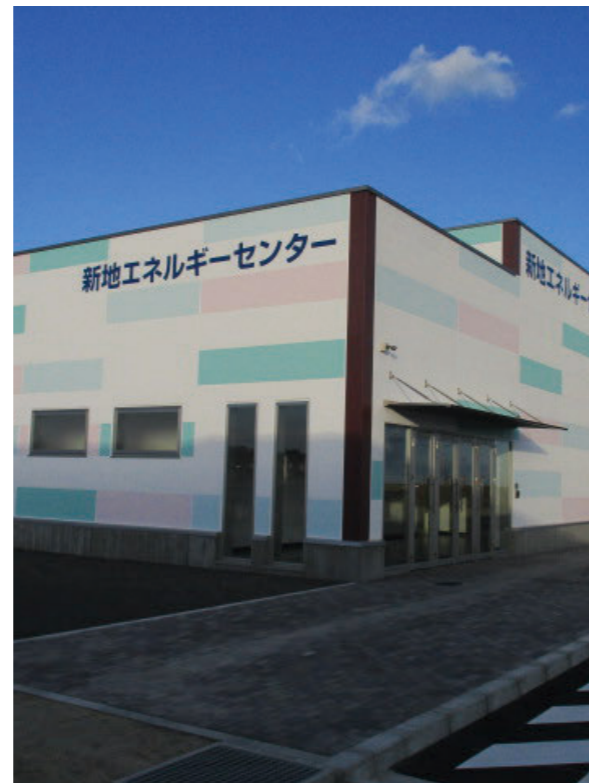
新地エネルギーセンター
