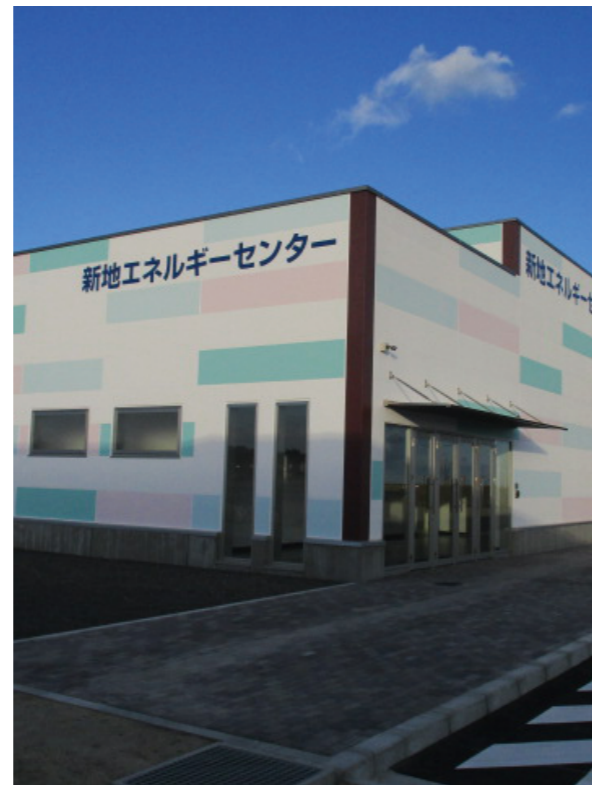
新地エネルギーセンター
