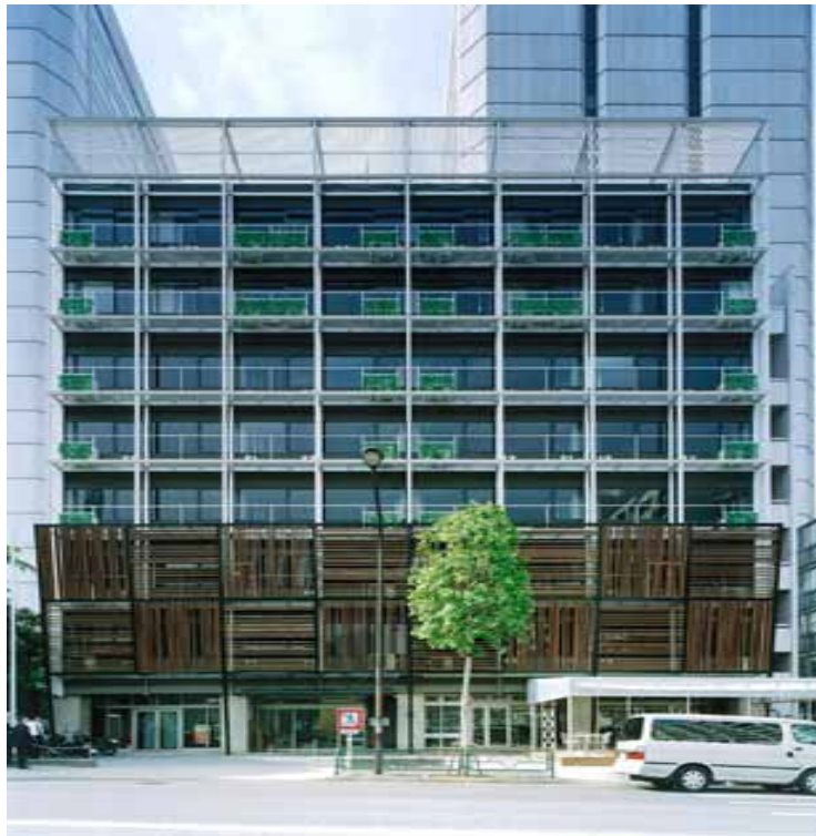
Lattice aoyama (日土地青山ビル)
