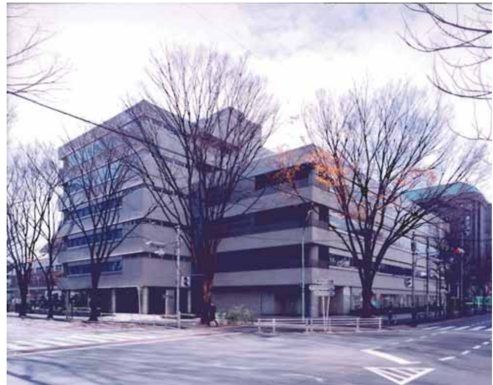
アーバンネット中野ビル
