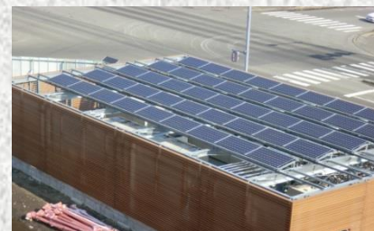
太陽光パネル
