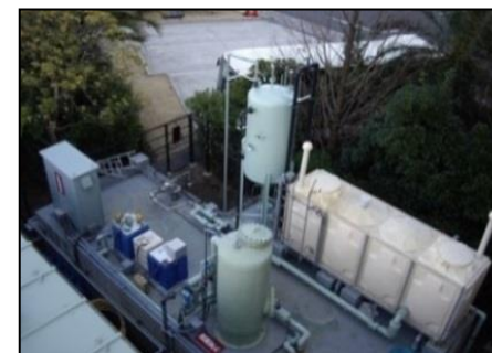
【天然ガスコージェネレーションシステム】
