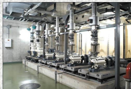
受水槽・揚水ポンプ
