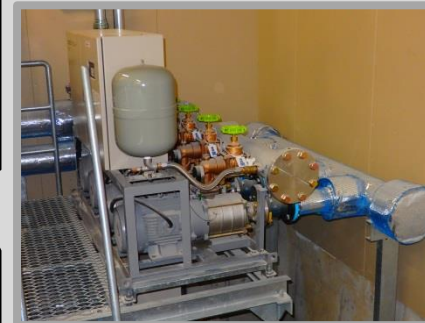
上水加圧給水ポンプ
