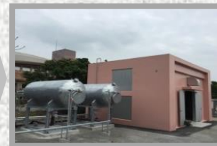
ガスタンク・制御機器室
