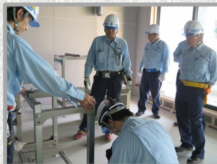
社長による現場視察
