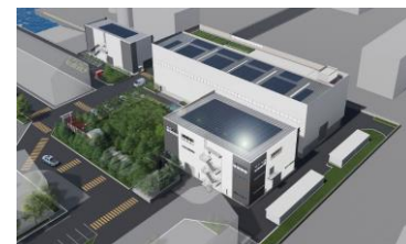
『ZEB』取得 【東亜建設技術研究センター第二実験棟】
