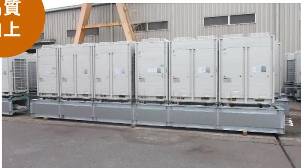
工場にて室外機・架台・冷媒管をユニット化
