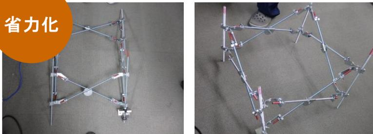
吊ボルトによる機器耐震振止め支持省力化
