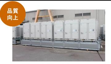
工場にて室外機・架台・冷媒管をユニット化
