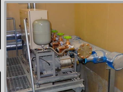
上水加圧給水ポンプ
